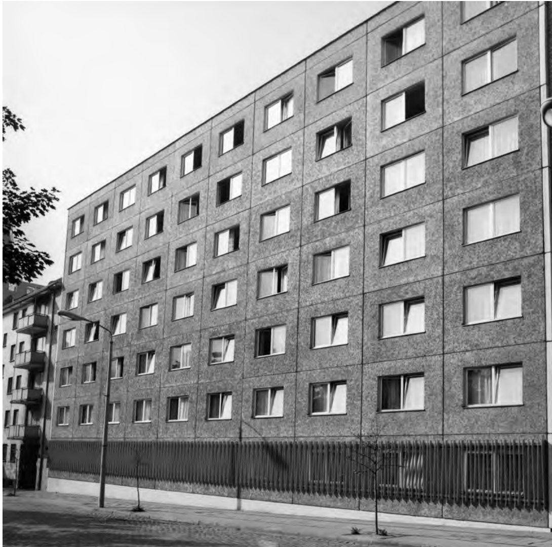
↑ Abb. 193: Der Sitz der ZAIG auf der westlichen Seite der Magdalenenstraße. Auffällig waren bei dem Neubau die überdimensionierten Gitter vor den Fenstern des Erdgeschosses, die die Sicht auf die Innenräume einschränken sollten. Genutzt wurden von der ZAIG in der Magdalenenstraße auch das Haus 6, ein im Jahr 2020 abgerissenes Wohnhaus aus der Gründerzeit, und drei Etagen des Archivegebäudes Haus 8/9.
