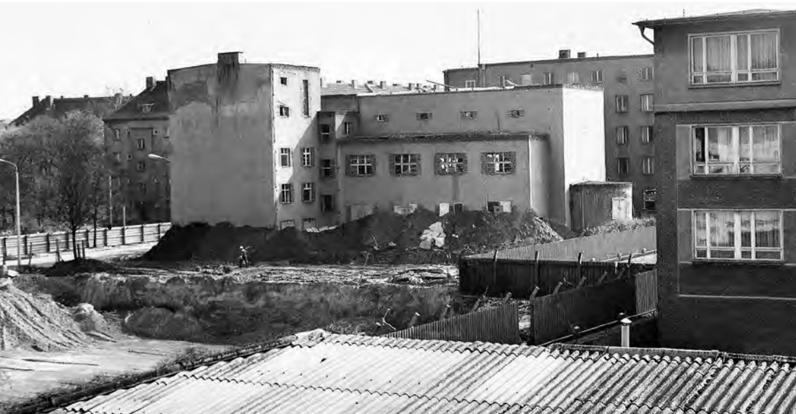
↑ Abb. 153: Die neuapostolische Kirche in der Normannenstraße. Vor der Sprengung wurden Erdwälle an den Außenwänden aufgeschüttet. Die Kirche erhielt einen Ersatzneubau am Münsterlandplatz in Berlin-Lichtenberg.
