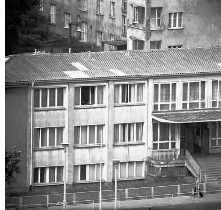
↑ Abb. 109: Die MfS-Poliklinik Mitte der 1970er-Jahre. Hinter der Poliklinik ist noch eines der 1979 abgerissenen Wohnhäuser des Bauhausarchitekten Bruno Taut zu sehen.
