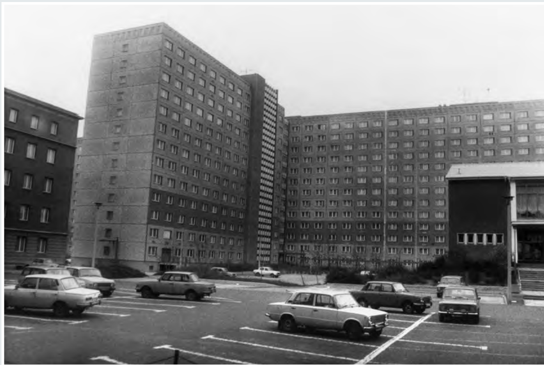
↑ Abb. 120: Der Gebäudekomplex der Auslandsspionage vom Innenhof der MfS-Zentrale aus gesehen. In dem in den Hof hineinragenden 13-Geschosser hatte der langjährige Leiter der HV A Markus Wolf in der 9. Etage sein Büro. Das Büro seines Stellvertreters und Nachfolgers Werner Großmann lag in der darüberliegenden Etage. Unter dem Gebäude gab es einen ABC-Schutzraum für die HV-A-Führung. Ausgestattet war dieser mit einer verstärkten Betondecke, einer Zugangsschleuse und Luftfiltern, auch eine kleine Handbücherei war vorgesehen. Ein Kriechgang führte auf den Innenhof.
