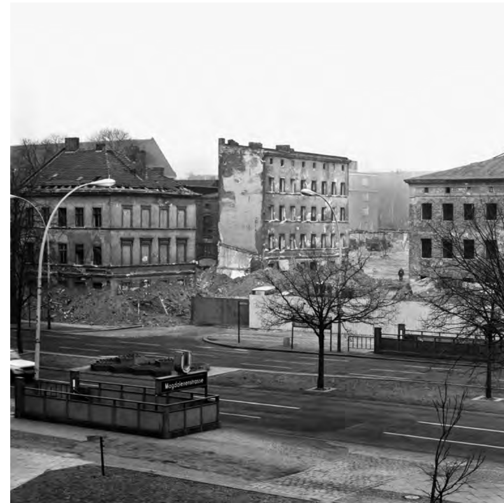
↑ Abb. 116: Gebäude an der ehemaligen Müllerstraße kurz vor ihrer Sprengung 1976. Die Müllerstraße wurde beseitigt, um Platz für die neuen 13-geschossigen Plattenbauten schaffen. An der Frankfurter Allee gut erkennbar sind die Ausgänge der U-Bahnstation Magdalenenstraße.
