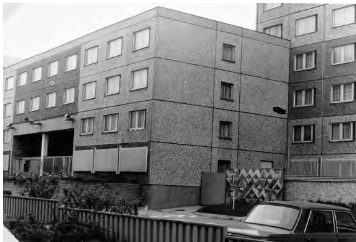
➤ Abb. 141: Neubauten sollten möglichst gut gegen die Umgebung abgeschirmt und gesichert sein. Die Fenster von Haus 17 erhielten im Erdgeschoss Gitter vor den Fenstern und eine Spezialverglasung, die verhinderte, dass man von außen hineinschauen konnte. Die Sichtbleche vor dem Parkplatz sollten verhindern, dass Passanten die Nummernschilder der MfS-Autos lesen konnten.
