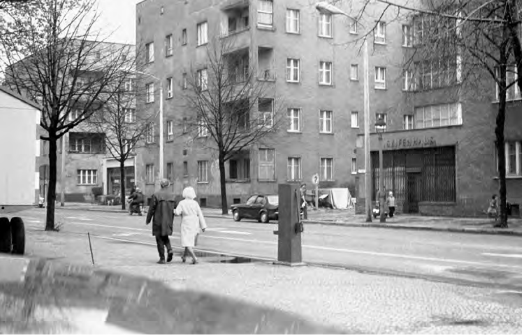
↑ Abb. 152: „Baufeldfreimachung“ für die Errichtung von Haus 18: Die Wohnhäuser von Bruno Taut in der Normannenstraße kurz vor ihrer Sprengung durch das MfS am 30. Januar 1979.
