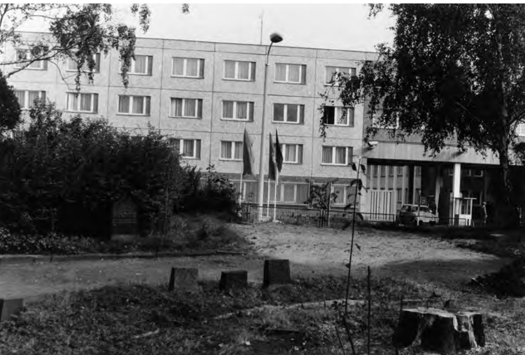
↑ Abb. 137: Haus 17 – am rechten Rand des Gebäudes die Zufahrt zur MfS-Zentrale vom alten Lichtenberger Friedhof aus fotografiert.
