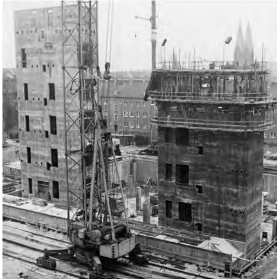
↑ Abb. 171: Bau von Haus 43, dem Nachrichtenfunktionsgebäude der Abteilung N, das 1979 übergeben wurde. Das Foto zeigt die Gleitkerne im November 1977, die die am Boden gegossenen Geschossdecken zentrieren, wenn diese in die jeweiligen Etagen gehoben werden.
