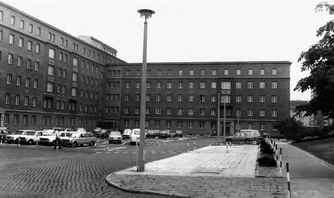
↑ Abb. 41: Haus 7 mit dem Innenhof der MfS-Zentrale Mitte der 1980er-Jahre.
