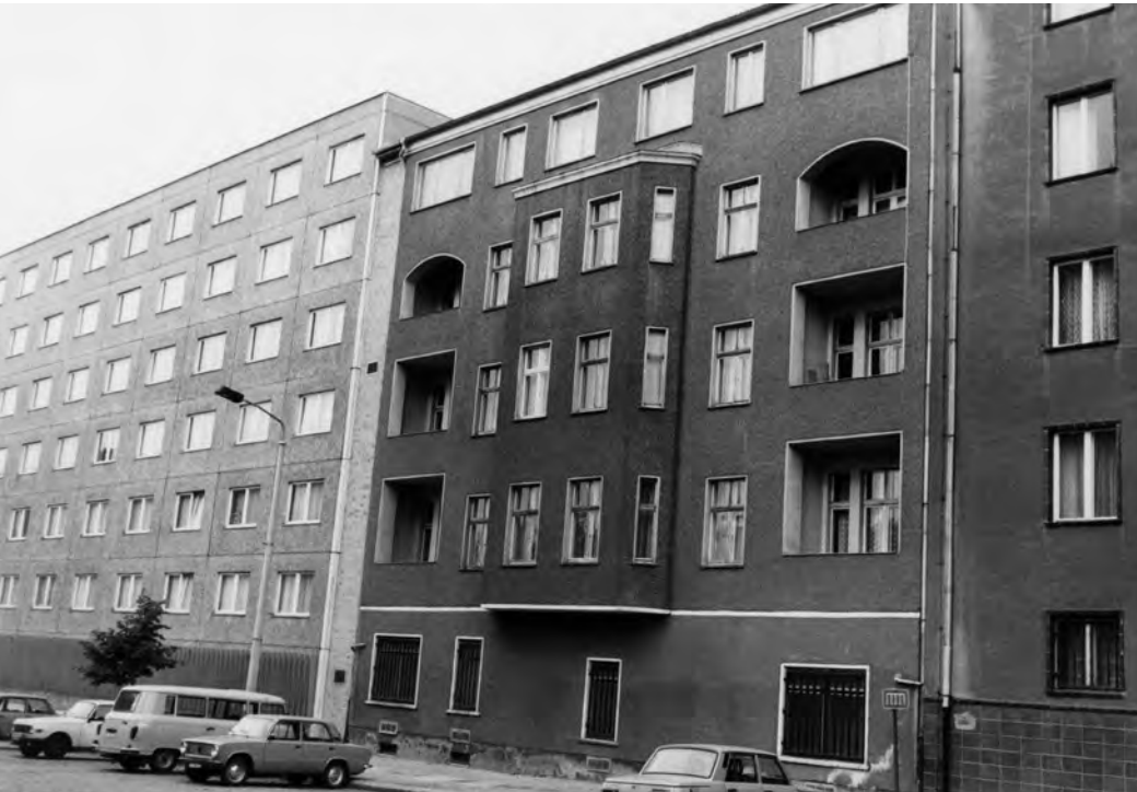
↑ Abb. 191: Gebäude des Zentralen Operativstabes auf der westlichen Seite der Magdalenenstraße. Mit der Übernahme des ehemaligen Wohnhauses durch das MfS erhielt das Erdgeschoss ein verändertes Aussehen: Die vordere Haustür wurde zugemauert und die Fenster vergittert. Die Fenster der obersten Etage wurden ebenso ausgewechselt und durch große, das Fassadenbild störende Fenster ersetzt. Rechts noch eine Fensterachse von Haus 2, links der Dienstsitz der Zentralen Auswertungs- und Informationsgruppe, Haus 4.
