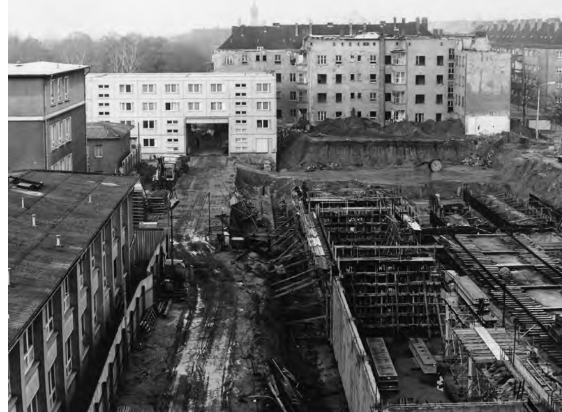
↑ Abb. 138: Haus 17 während der Bauphase vom Hof aus gesehen. Haus 17 verfügte über eine zweite Durchfahrt (hier im Bild), die mit Blech-toren komplett verschlossen und für den Notfall da war. Rechts davon noch die zum Abriss bestimmten Altbauten, die dann Haus 18 wichen. Im Vordergrund die Fundamenteinschalung für den Neubau von Haus 18.
