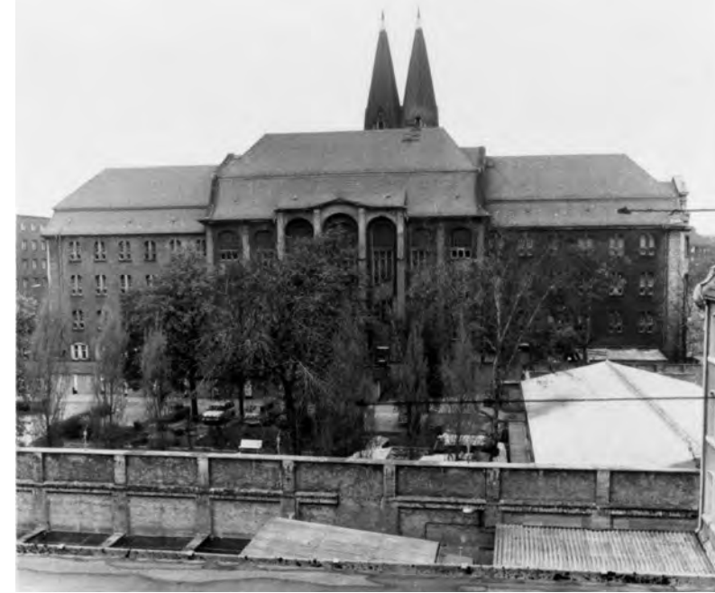
↑ Abb. 181: Blick auf das Amtsgericht über die Gefängnismauer, die die Freiganghöfe begrenzt.
