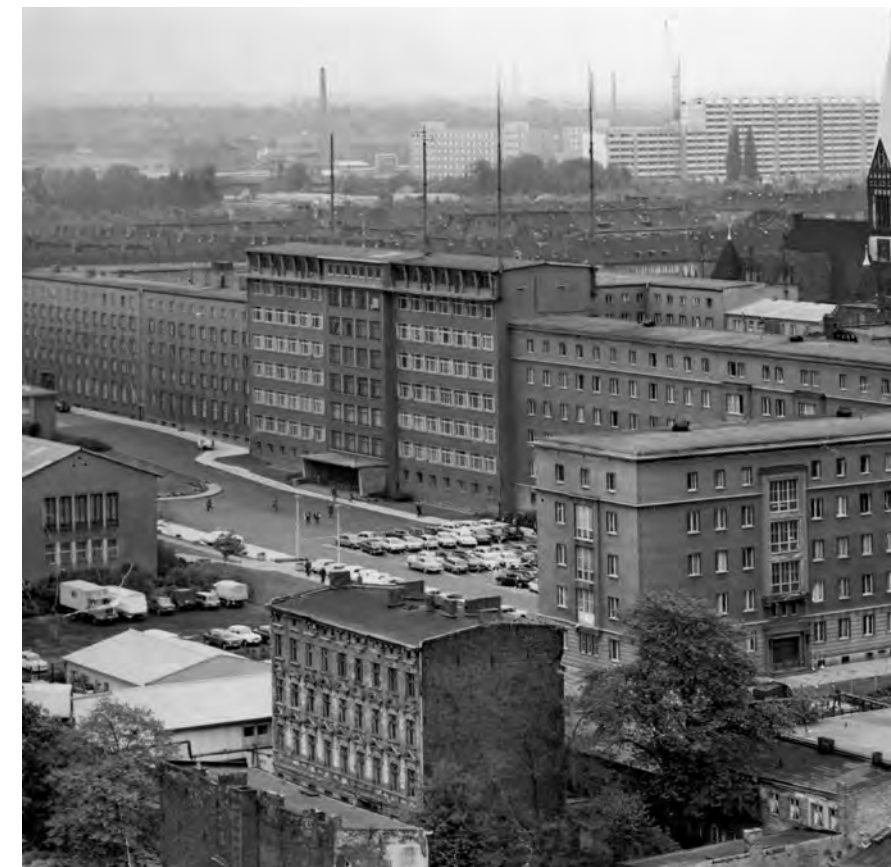
➤ Abb. 75: Haus 1 mit dem mit Glastüren versehenen Haupteingang Ende der 1960er-Jahre. Rechts davor Haus 7 und links von Haus 1 das ehemalige Finanzamt.
