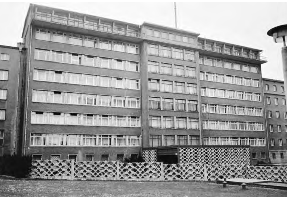
↑ Abb. 64: Frontfassade von Haus 1 mit dem Sichtschutz für den Eingangsbereich in den 1970er-Jahren.
