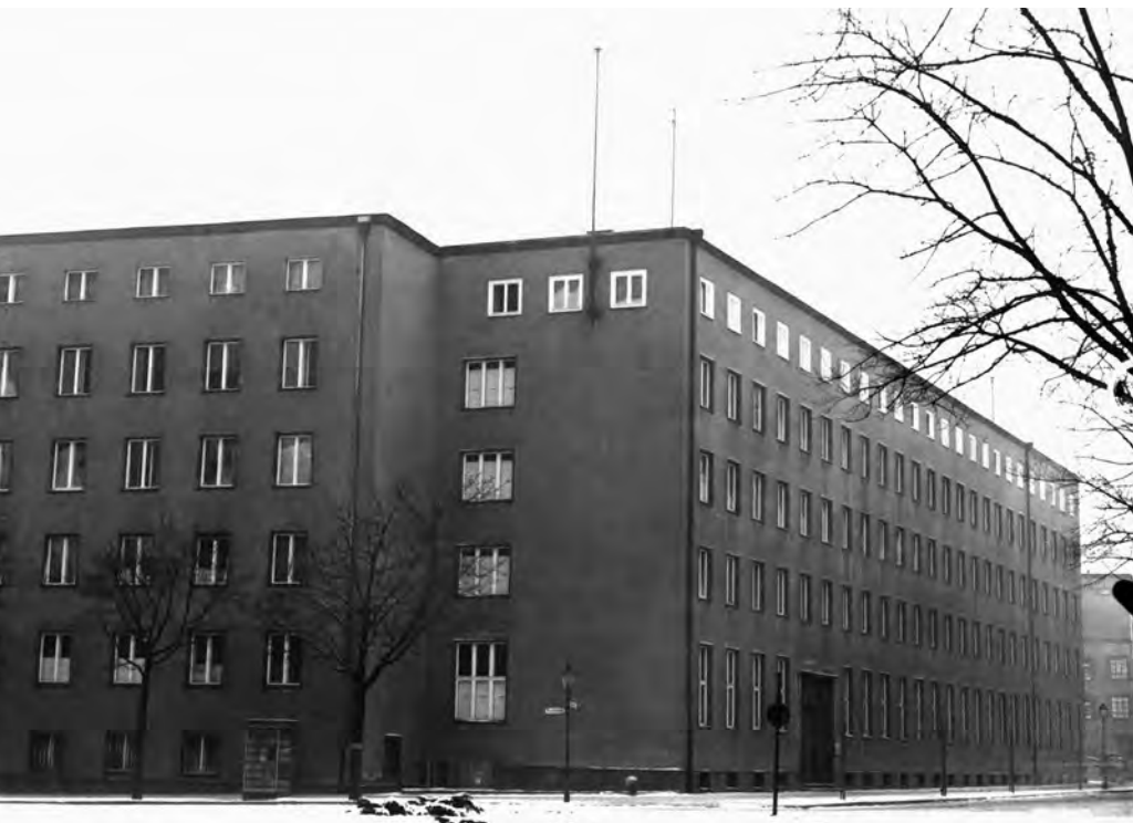
↑ Abb. 4: Das ehemalige Lichtenberger Finanzamt, der erste Sitz des Ministeriums für Staatssicherheit Ende der 1950er-Jahre. Erkennbar ist, dass einige Fenster im 1. Geschoss und im Eckbereich von innen mit Schwemmkreide geweißt wurden. Der Anstrich diente als Sichtschutz nach außen.
