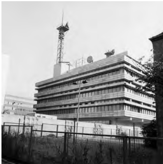
↑ Abb. 172: In Haus 43 gab es eine trümmersichere Decke, um im Kriegsfall die nachrichtentechnische Infrastruktur aufrechterhalten zu können. Zur kabeltechnischen Erschließung wurden 120 Leitungsstränge (Züge) gebaut, die man zur Absicherung in Druckluftschläuchen verlegte. Mittels eines Kompressors, der sich im Keller befand, wurde der Luftdruck in den Schläuchen auf einem konstanten Niveau gehalten. Hätten ausländische Nachrichtendienste eine der Verbindungen angezapft, wäre es zum Druckabfall gekommen und die Abhöraktion wäre aufgefliegen.
