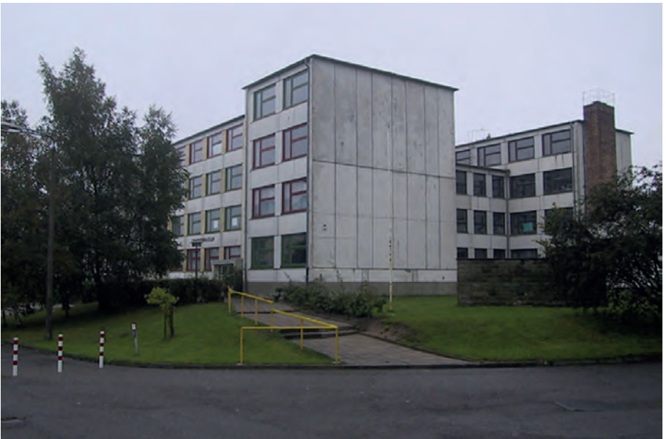
Hier soll Joraschkewitz das »Showbusiness« aufgeführt haben. Das Schulgebäude der KJS des SC Traktor Schwerin; Aufnahme aus den 2000er-Jahren, vor der Sanierung
