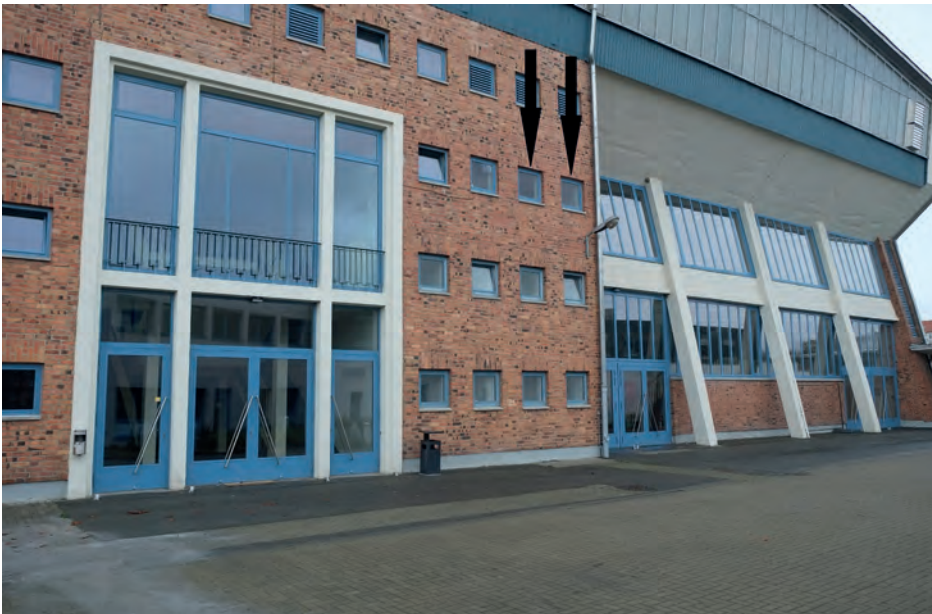
Die Fenster (Pfeile) des ehemaligen Raums 19 der Sport- und Kongresshalle auf der Stadionseite in der Außenansicht; November 2015
