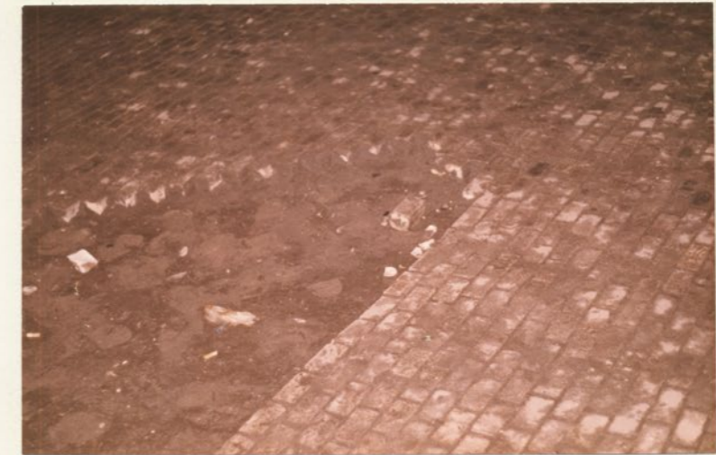
Herausgebrochene Pflastersteine aus dem Gehweg vor dem Hauptbahnhof Dresden und nach den Aufräumarbeiten
