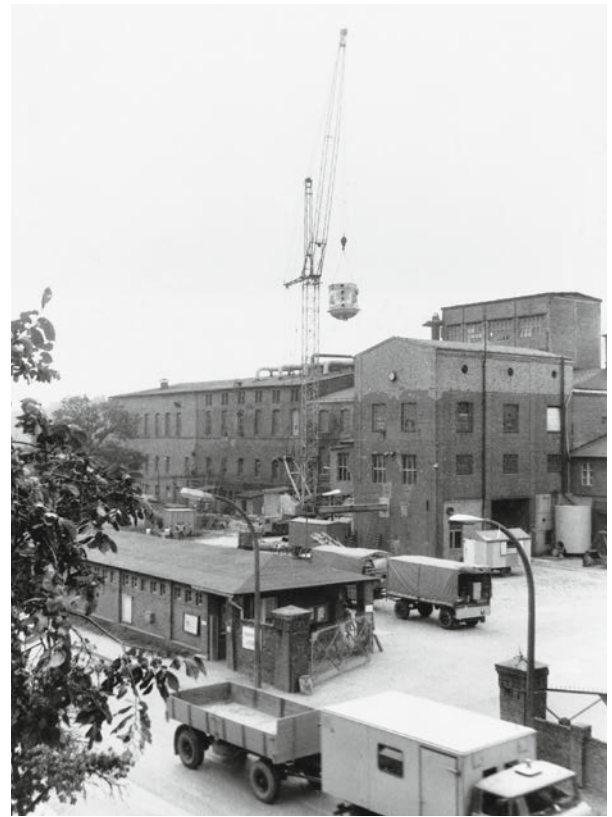
> Letschiner Zuckerfabrik beim Einbau eines Verdampfapparates. 1987 Letschiner Heimatstube
