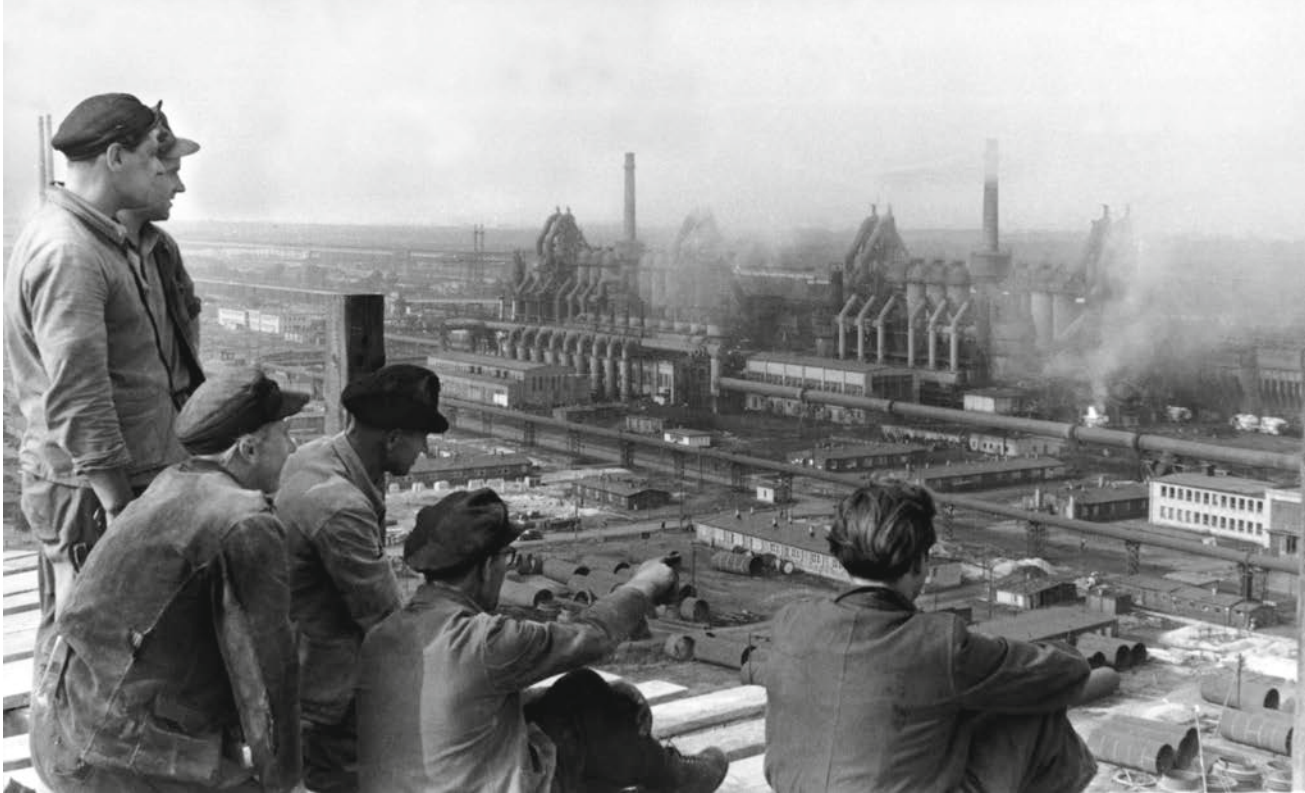
> Blick von einem Kühlturm auf Hochöfen des Eisenhüttenkombinats »J. W. Stalin«. August 1954 BArch, Bild 183-26067-0009, Foto: Horst Sturm
