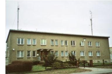
KD Teterow (ab 1974) Güstrower Str. 18 (vorheriger Sitz Malchiner Damm) BArch, Außenstelle Neubrandenburg
