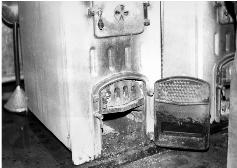
> Asche von verbranntem Papier in der Heizungsanlage der Stasi- Dienststelle in Röbel. 5.12.1989 Fotograf: unbekannt
