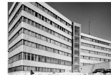
KD Suhl (ab 1952) Hölderlinstr. 1 BStU, MfS, BV Suhl, ZPL, Fo, Nr. 7, Bild 1 (Neubau, errichtet 1975-1978)
