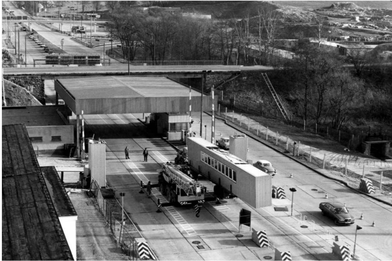
> Tatortspuren wurden verwischt: Nach dem Ende des SED-Regimes wurde im März 1990 die Brücke zur Durchleuchtung von Fahrzeugen an der Grenzübergangsstelle Hirschberg, hier bereits abgeladen auf dem Lkw, entsorgt. In der konspirativen Anlage setzte das MfS radioaktives Cäsium 137 ein. 8.3.1990
