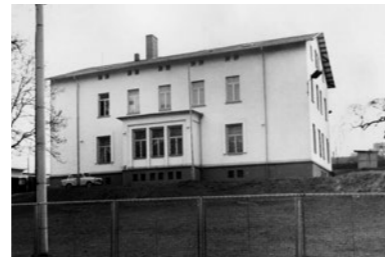
KD Meiningen Thälmannstr. 5 (heute Neu-Ulmer Str.) BStU, MfS, BV Suhl, KD Meiningen, Nr. 1110, Bl. 56
