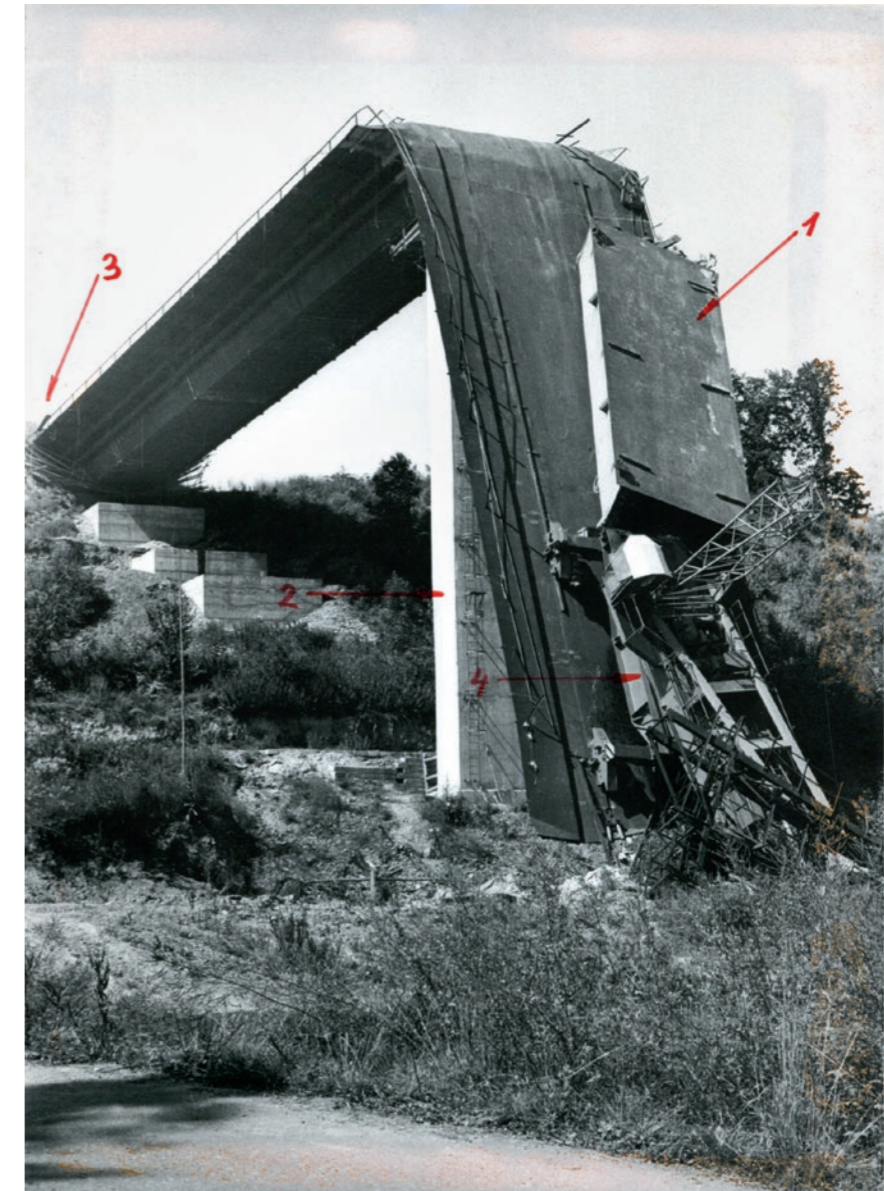
> Die zusammengebrochene Stauseebrücke von Zeulenroda. 1 – neu angeliefertes Hohlkastenelement; 2 – Pfeiler 1; 3 – Widerlager; 4 – Vorbaukran (Markierungen der Stasi). 13.8.1973 BStU, MfS, BV Gera, AS 492/75, Bd. 4, Bl. 134
