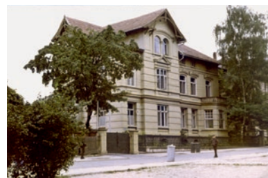
KD Sondershausen (bis 1969) Str. der Thälmannpioniere (heute Göldnerstr.) BStU, MfS, BV Erfurt, Leiter 1, Bl. 6, Bild 2
