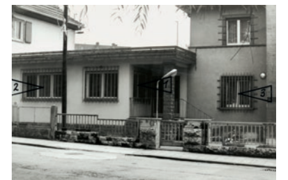
KD Langensalza Travertinstr. 4 BStU, MfS, BV Erfurt, KD Langensalza, Nr. 10, Bl. 29, Bild 2
