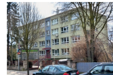
KD Erfurt (ab 1971) Str. der Einheit 8 (heute Alfred-Hess-Str.) BStU, Außenstelle Erfurt
