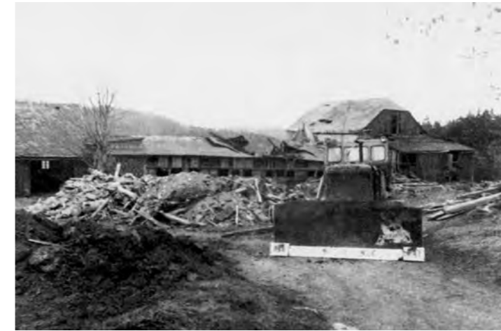
> Abriss des Burgsteinguts. 1986 Privat
