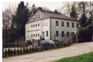
KD Zschopau Thumer Str. 428 BStU, Außenstelle Chemnitz
