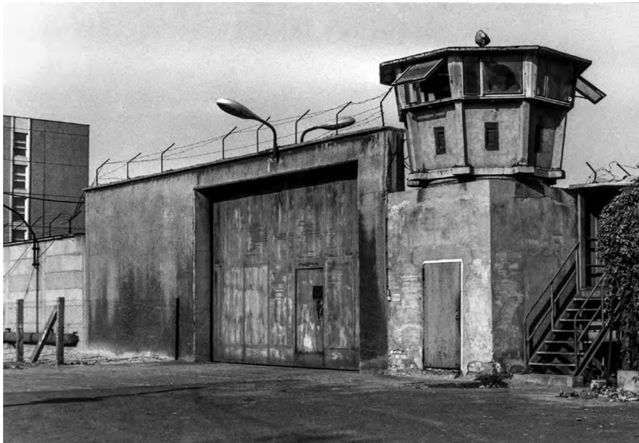
> Vorderfront der zentralen Untersuchungshaftanstalt des MfS in Berlin-Hohenschönhausen. Um 1985 BArch, MfS, HA IX, Fo, Nr. 2560, Bild 49
