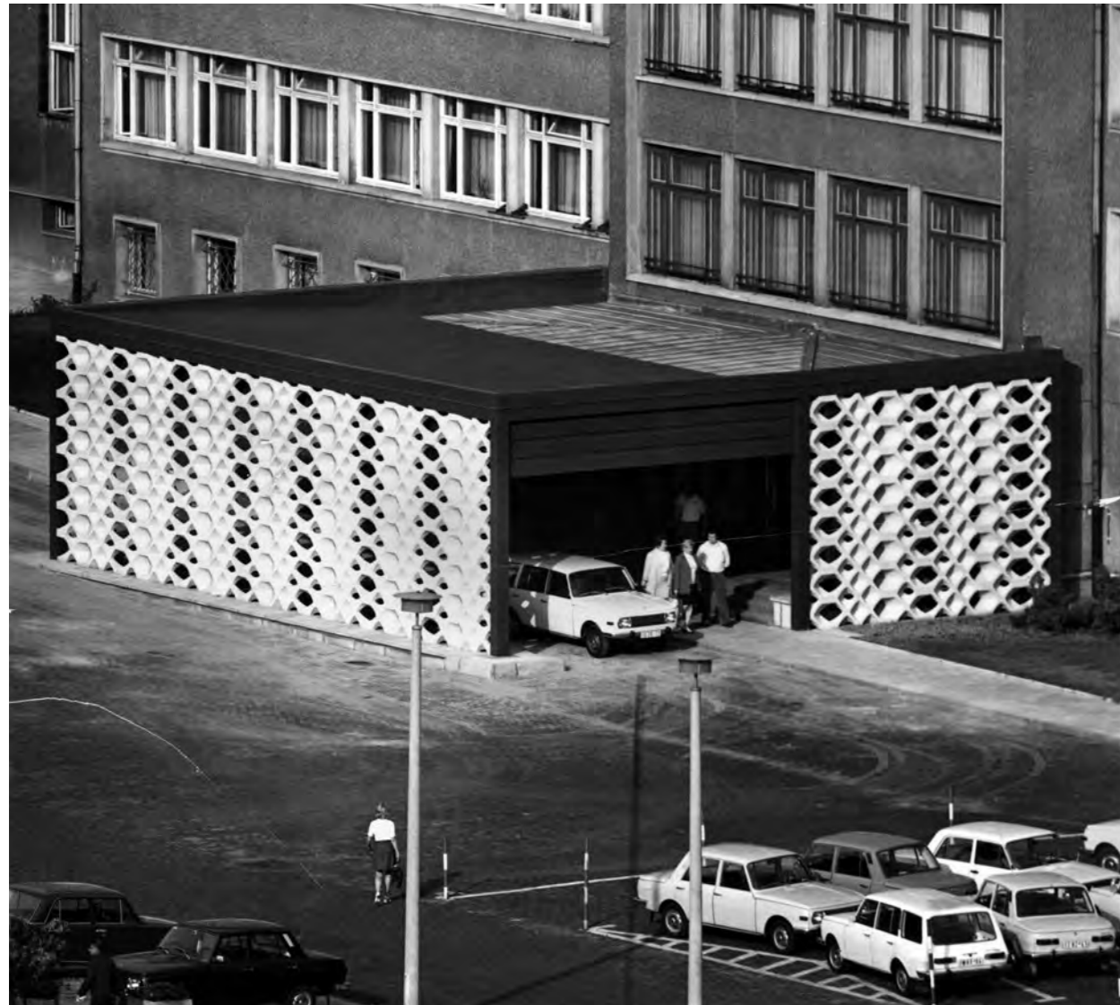
> Der Eingang zu Haus 1 mit Vorbau. Nach 1974 BArch, MfS, BdL, Fo, Nr. 227, Bild 8
