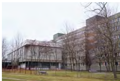
KD Marzahn (ab 1985) Straße der Befreiung 60 (heute Alt-Friedrichsfelde 60), Haus 1 (auf dem Gelände der BV Berlin) Foto: Mark Schiefer
